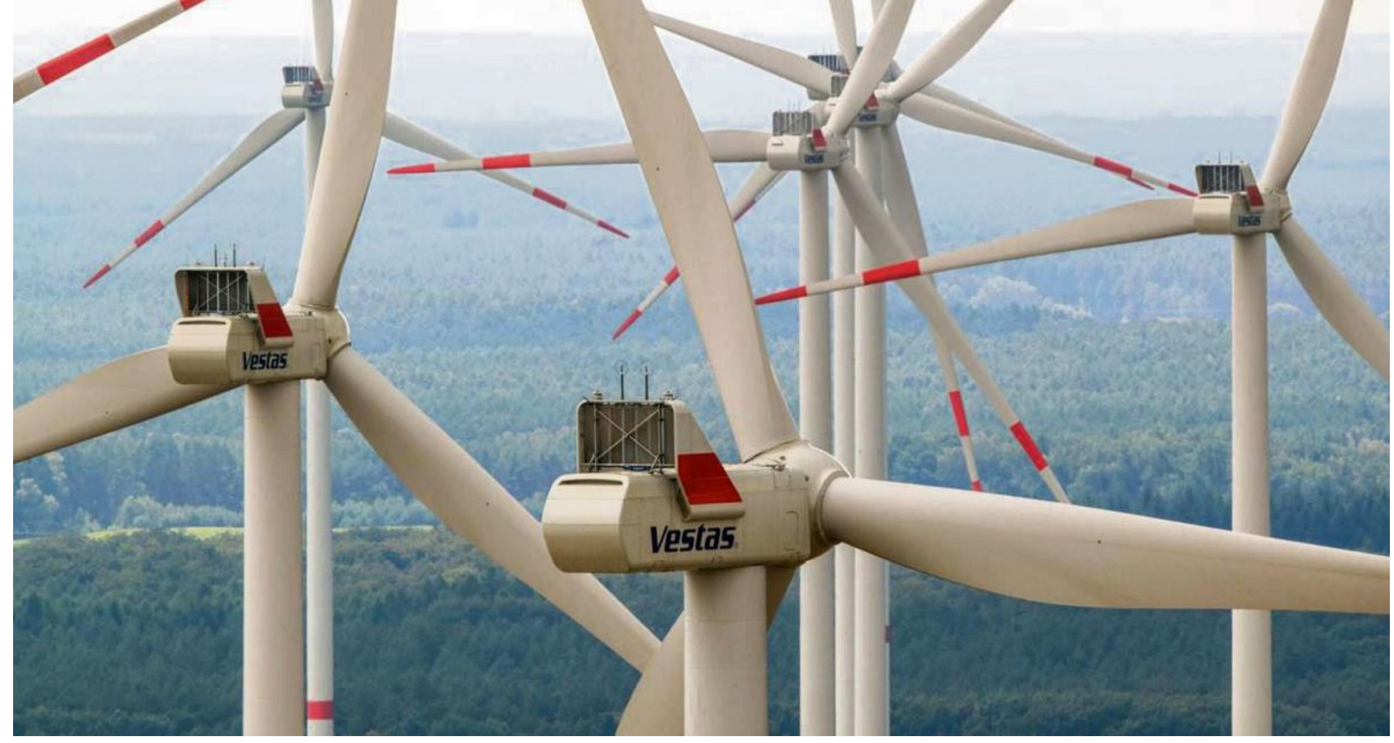
Nach dem endgültigen Ausstieg aus dem Windpark Olsberg richten die Stadtwerke den Blick nach vorn. In Meschede sollen sieben deutlich größere Anlagen gebaut werden, die jährlich 100 Millionen Kilowattstunden Strom liefern sollen.
