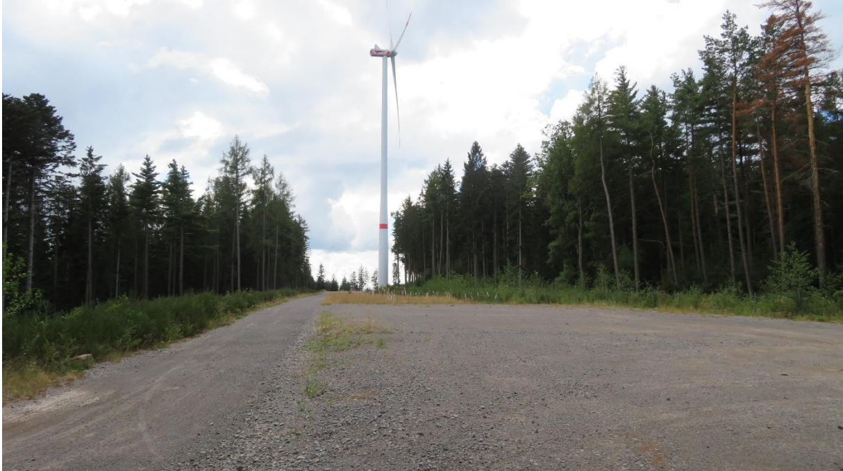
Bild 9: Dauerhaft gerodeter Wald für die Arbeitsfläche eines Windkraftwerkes auf dem Stillfüssel
