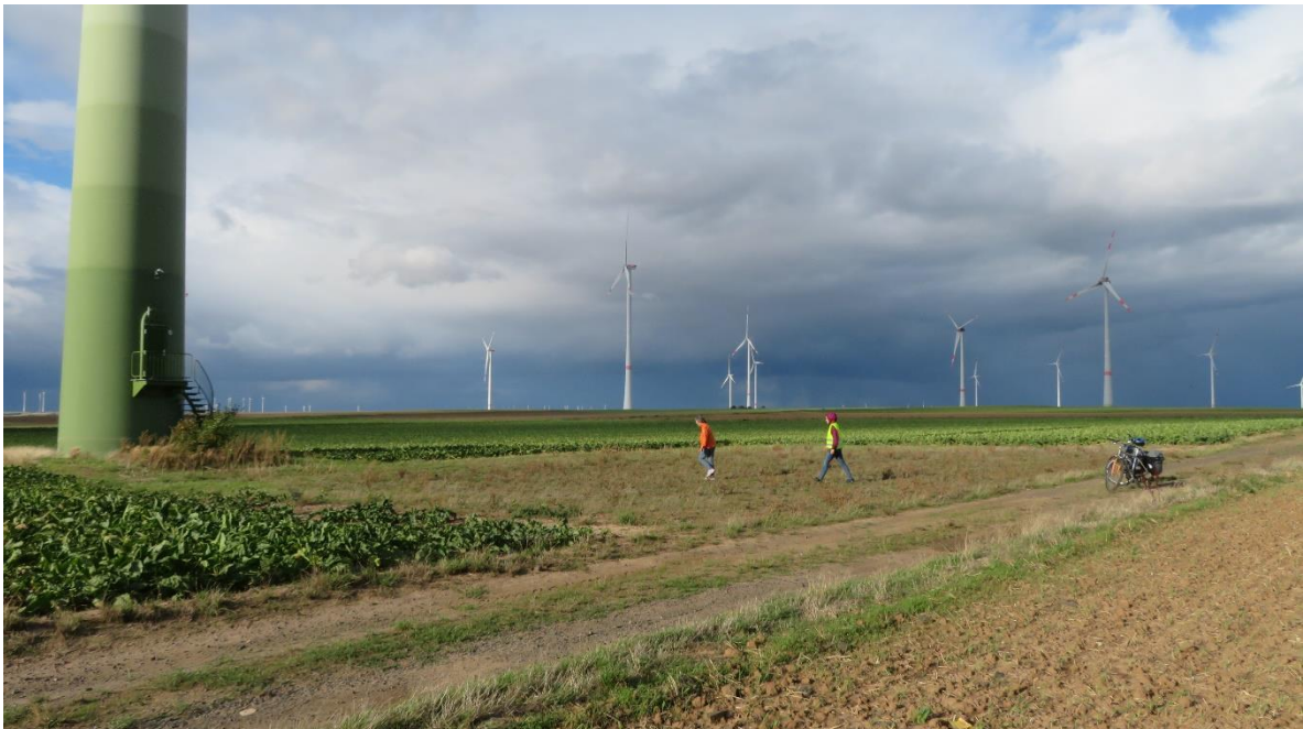
Bild 30: Windkraftwerke bei Biedesheim/Pfalz
