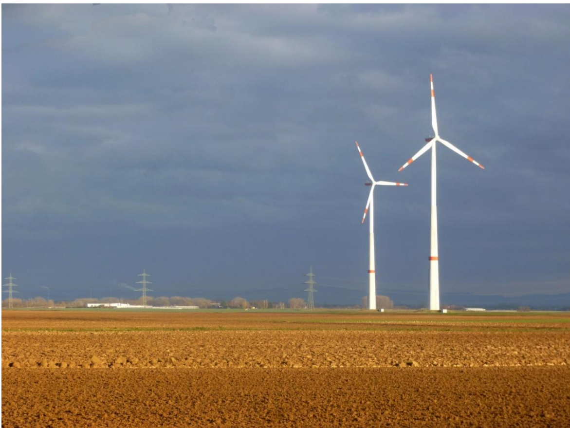
Bild 34: Windkraftwerke in der Rheinebene auf landwirtschaftlichen Flächen bei Haßloch/Pfalz
