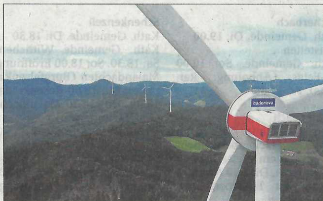
Beim Windpark Hohenlochen stehen zwei Anlagen still, weil die Rotorblätter ausgetauscht werden müssen. Foto: Badenova
